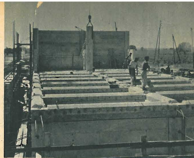
L'impermeabilità del calcestruzzo precompresso lo rende particolarmente indicato per la fabbricazione di serbatoi, tini, tubi. La fotografia rappresenta la fabbricazione di grandi tini presso gli stabilimenti Cinzano a Baillargues (nell'Hérault); sono visibili le estremità dei cavi di tensione.
