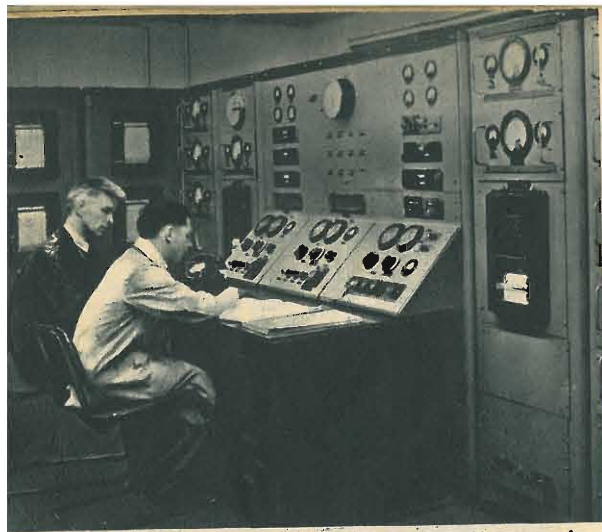
Questa fotografia mostra il quadro di comando a distanza dove sono riuniti i quadranti degli apparecchi di misura ed i registratori della Gleep.
